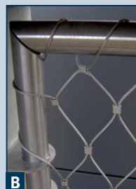
Netz, geschlossen, mit Leerhülsen Net closed with open ferrules Maille fermée, avec manchons libres
